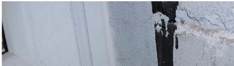
Bild 5: Eckausführung bei Version „IM“. Immer wenn ein neuer Streifen in den Ecken mit einem schon montierten Streifen des Anschlussbandes überlappt, wird wieder WFlex-TFS oder WFix-Kleber auf das schon montierte Band aufgebracht, sodass auch die Enden des neuen Bandes fest in den Kleber eingedrückt werden können und die Band-Enden vollständig im Kleber eingebettet sind.
