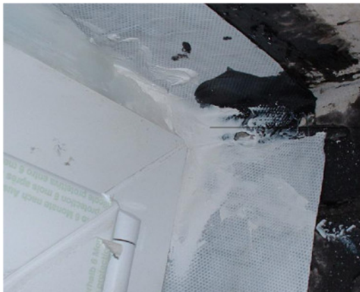
Bild 4: WFlex-TFS oder WFix zur Eckabdichtung. Die Band-Enden werden fest in den Kleber eingedrückt.
