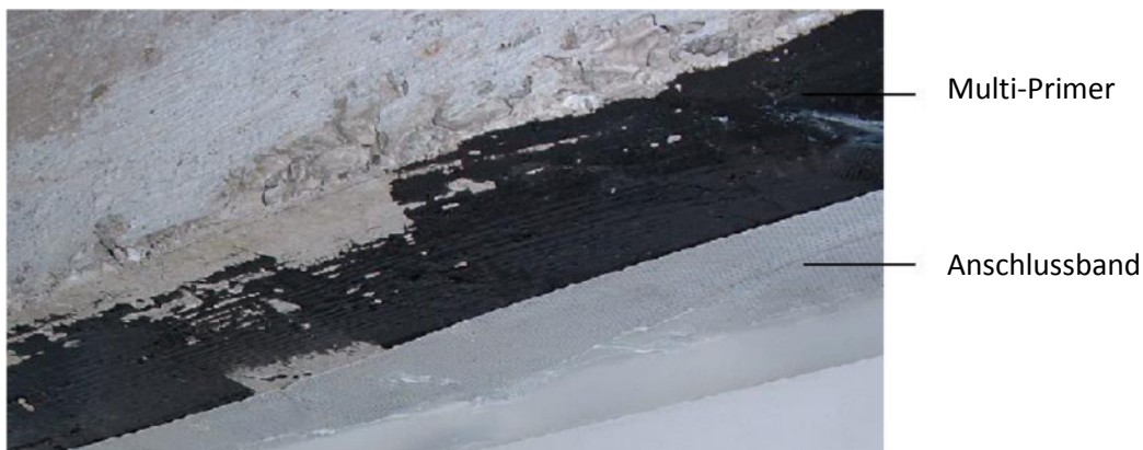
Bild 1 (Leibung geprimert mit Multi-Primer)
